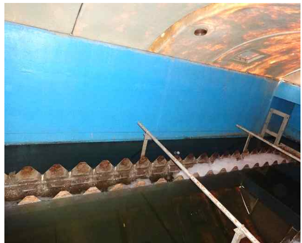
2지 내부 벽체 상태 양호
